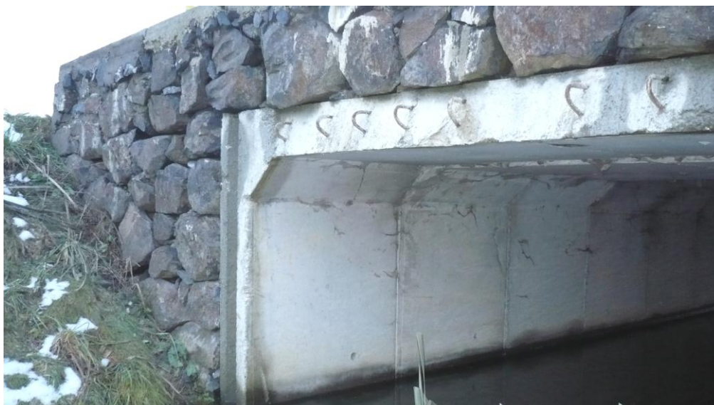
Uplatněné rámové prefabrikáty, nemaltovaná balvanitá rovnanina v líci čel
